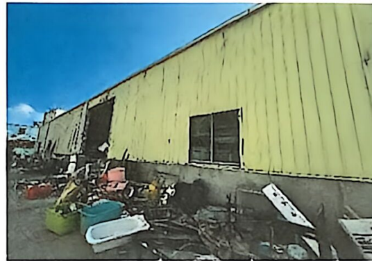
照片说明：黄色钢结构仓库
