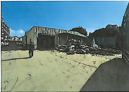
照片说明：黄色钢结构仓库
