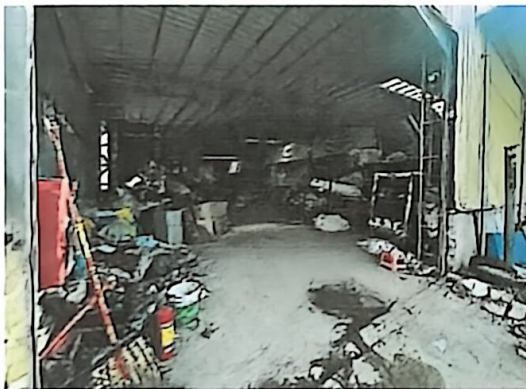
照片说明：黄色钢结构仓库
