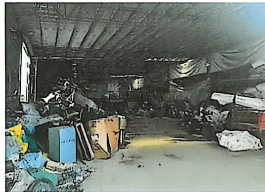
照片说明：黄色钢结构仓库
