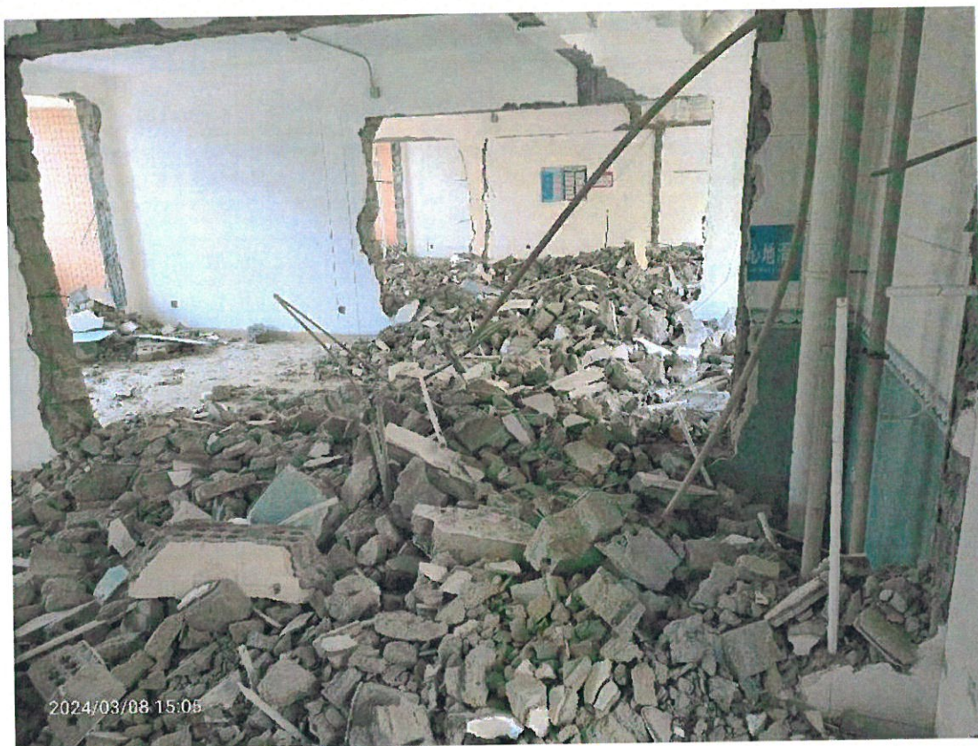
A 栋 2 楼 室 内
