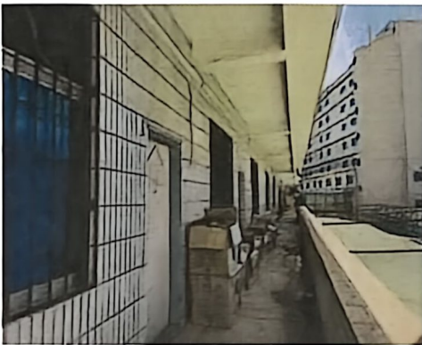
照片说明：第二栋酒店配套用房内部
