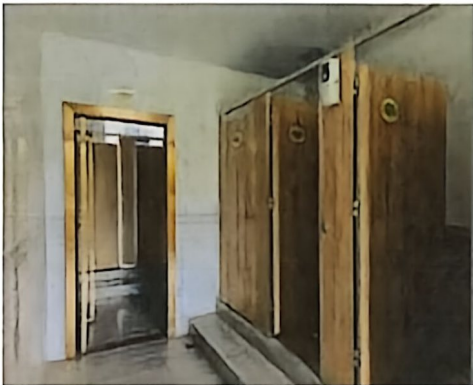
照片说明：第二栋酒店配套用房内部
