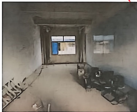
照片说明：第二栋酒店配套用房内部
